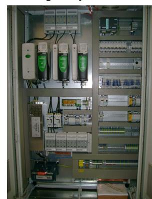
40 Nm montiert worden. Die Speisung der Motoren erfolgt über zwei IGBT-Frequenzumrichter und eine gemeinsame Rückspeiseeinheit.
